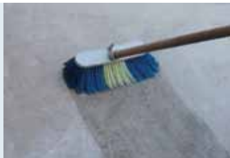
Yüzeyin temizlenip nemlendirilmesi
