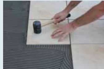
Çekiçle vurulup seviyelendirilmesi
