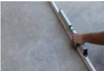
Yüzeyin düzgünlüğünün kontrol edilmesi
