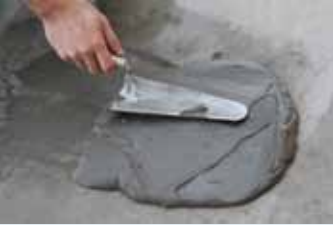
Harçın mala yardımı ile yüzeye aktarılması
