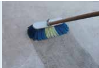
Yüzeyin temizlenip nemlendirilmesi
