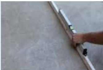
Yüzeyin düzgünlüğünün kontrol edilmesi
