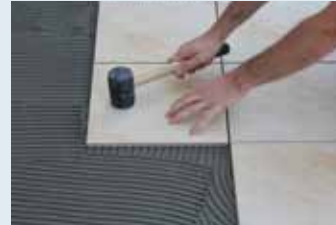
Çekiçle vurulup seviyelendirilmesi
